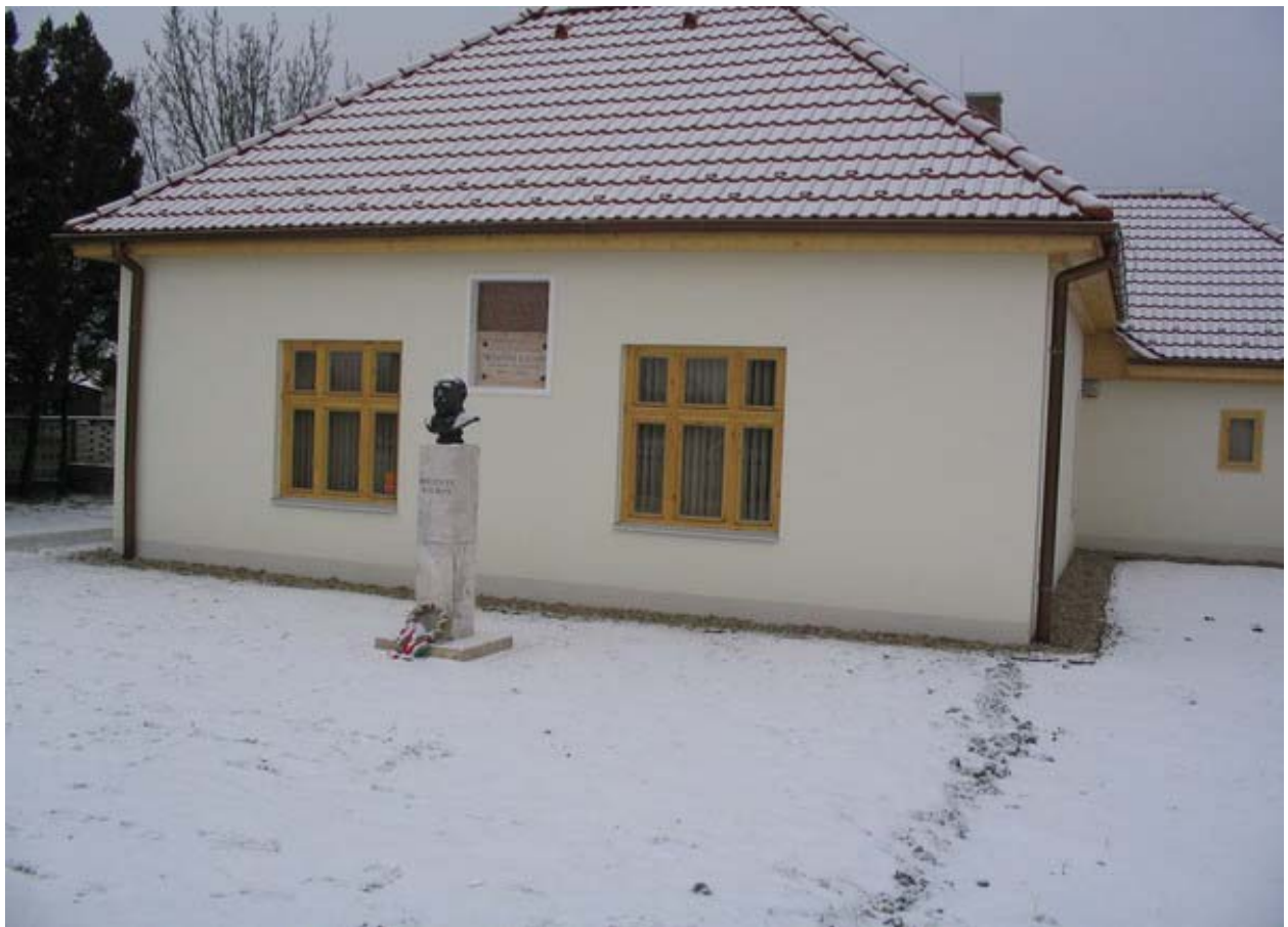
A felújított szklabonyai Mikszáth-ház
