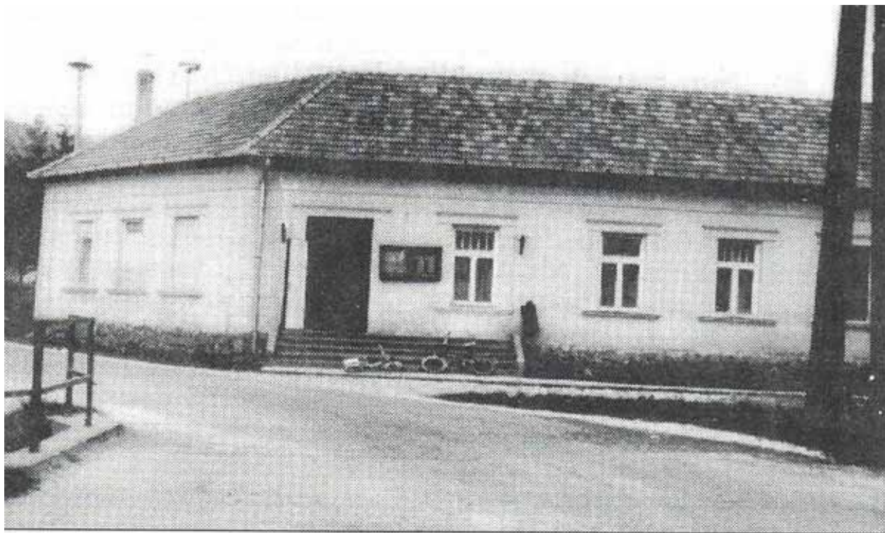
A kultúrház valamikor a Rosenberg kereskedőcsalád tulajdona volt
