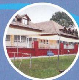
Óvoda felújítása több ütemben
