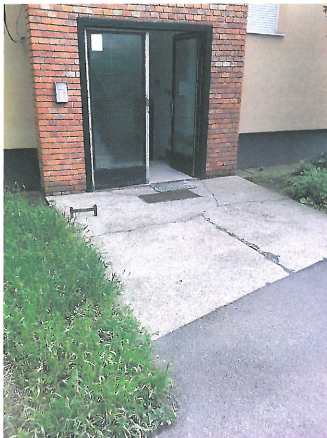
A lépcsőház előtti betonjárda
