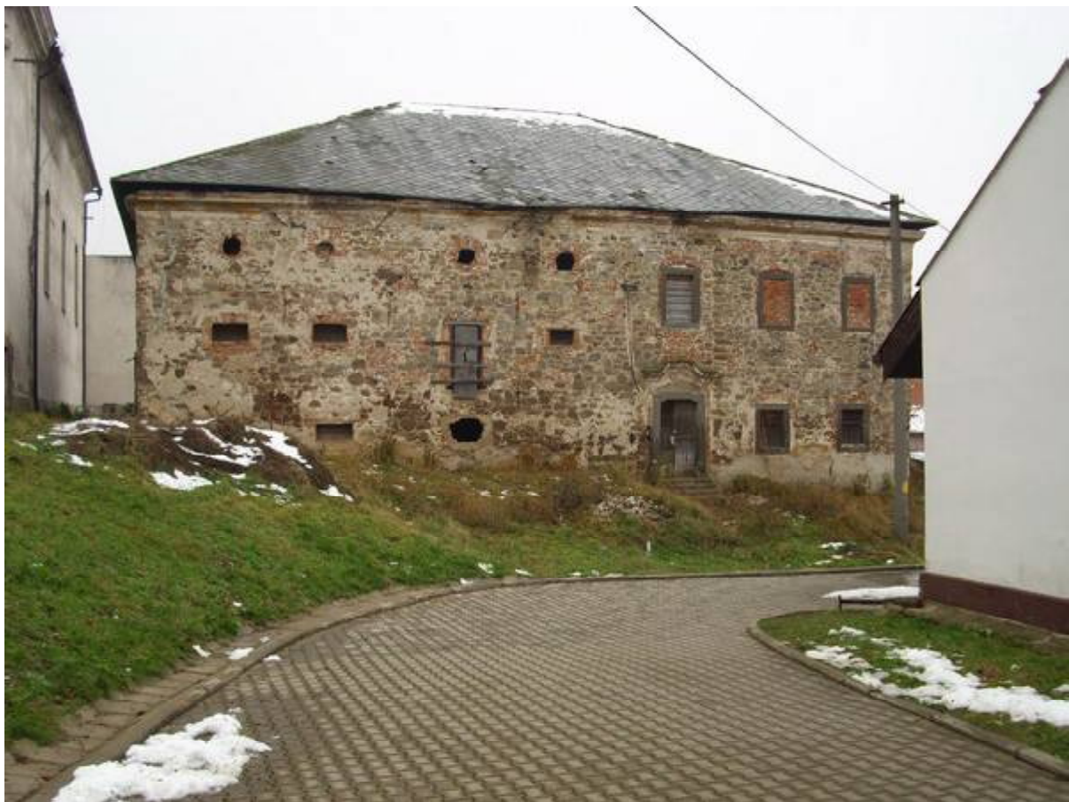
A premontreiek helyén emelt ipolysági jezsuita rendház épülete ma.
