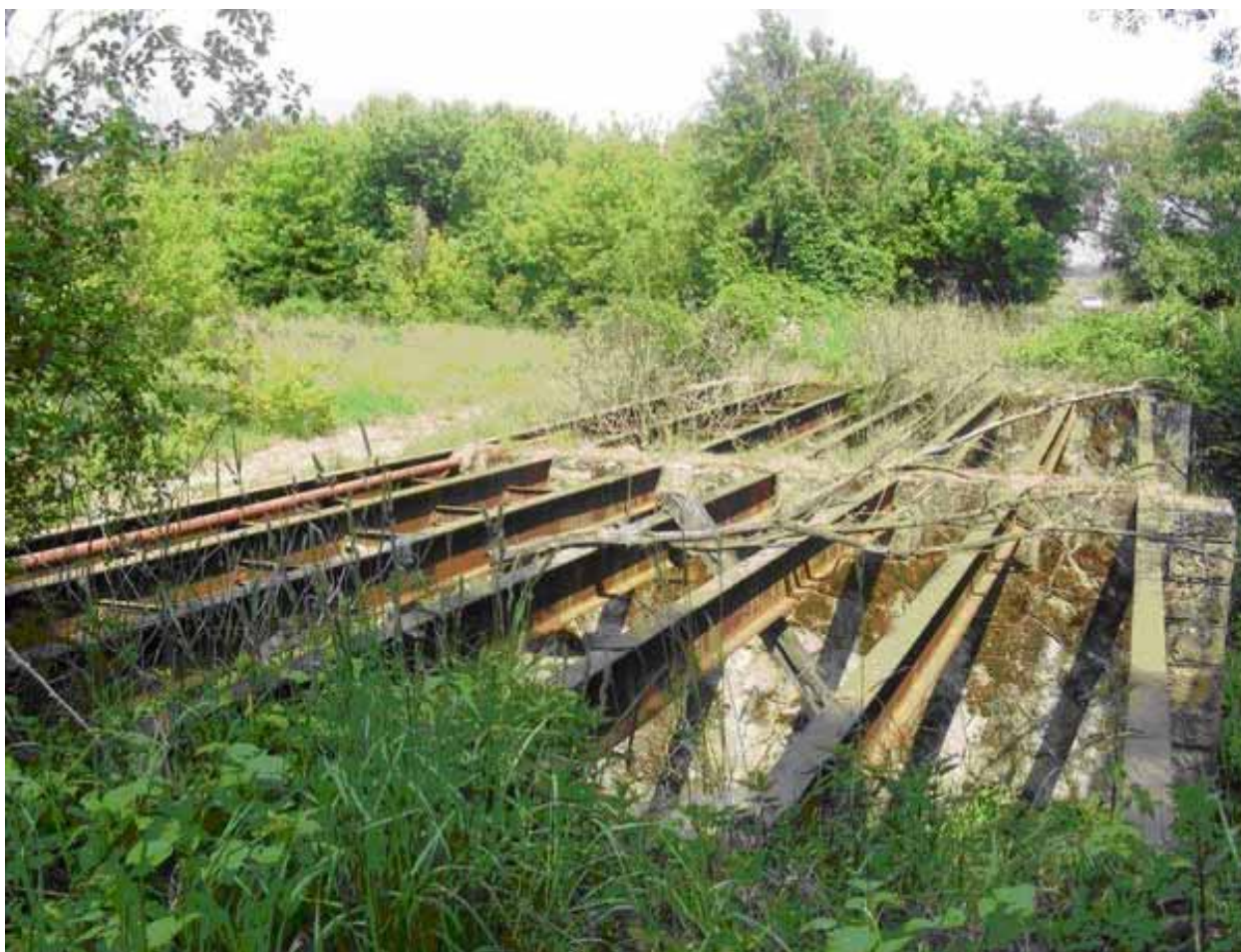
Az ártéri híd megmaradt kő- és acélszerkezete
