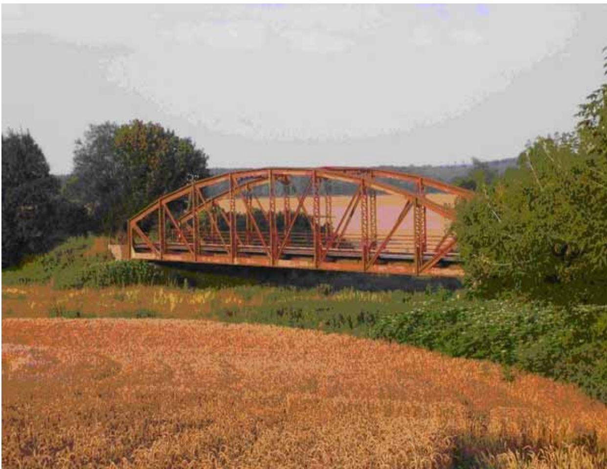
A vasúti híd Ipolyszakállos északi részén, 2009
